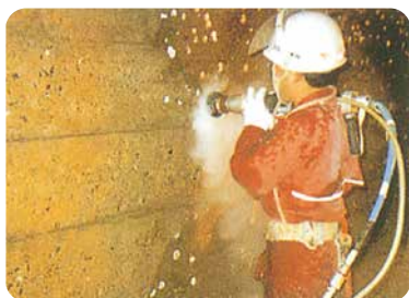
▶ 発電所取水口のマリンスケール およびライニングの除去
