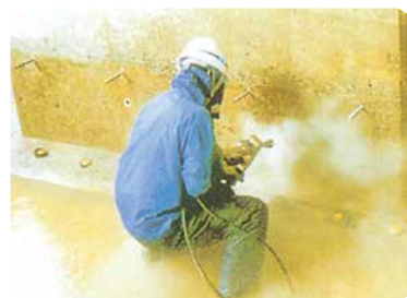
▶ 橋脚のコンクリートはつり
